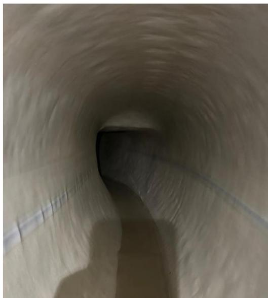
Figura 3. Condotta fognaria curvilinea con lieve abbassamento post risanamento CIPP Vapore (tratta 11 – 12)
